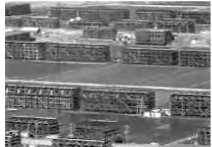
図2 流下式枝条架併用塩田 (出典: NHK 「日本の素顔」 (1) (1959))
