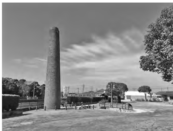
図24 旧越中屋釜屋煙突（登録有形文化財）
